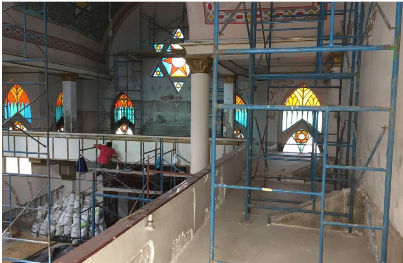
Un aspecto de las obras de la sede del CDIJUM.
